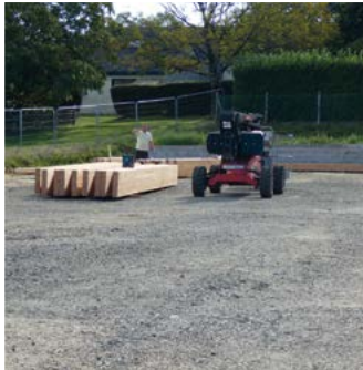
Le bois pour l'ossature du préau vient d'être livré.
